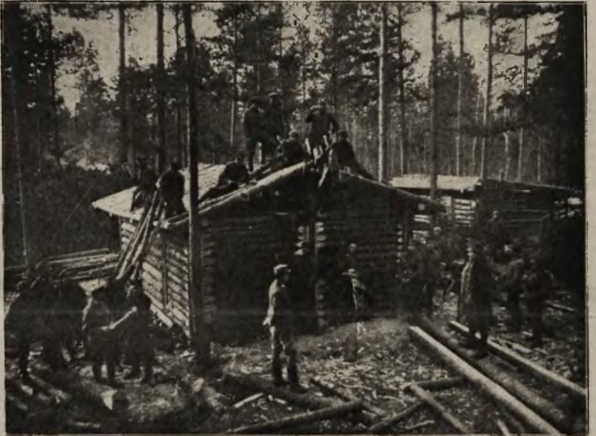
Szósty pułk Legionów w polu: Budowa kwatery komendy pułku
