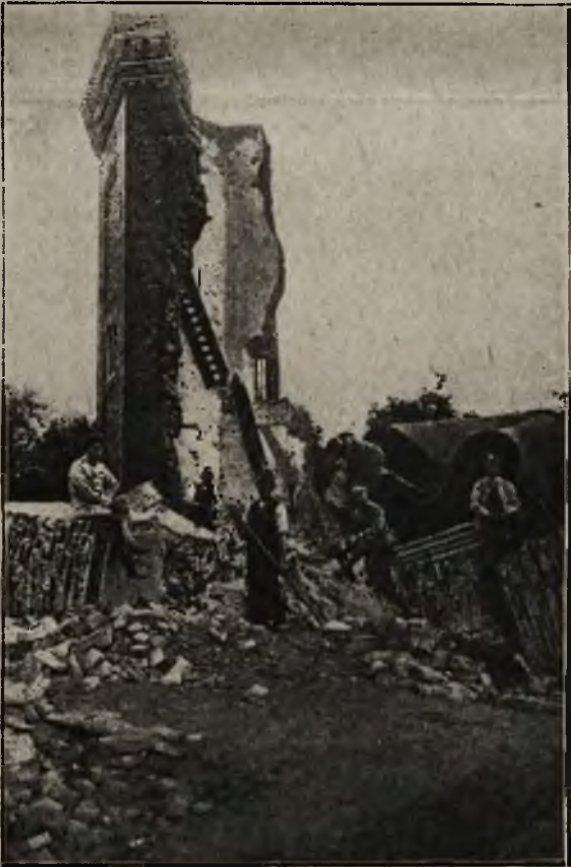
Wojna w Polsce: Zburzony rezerwar wodociągowy w Kielcach
