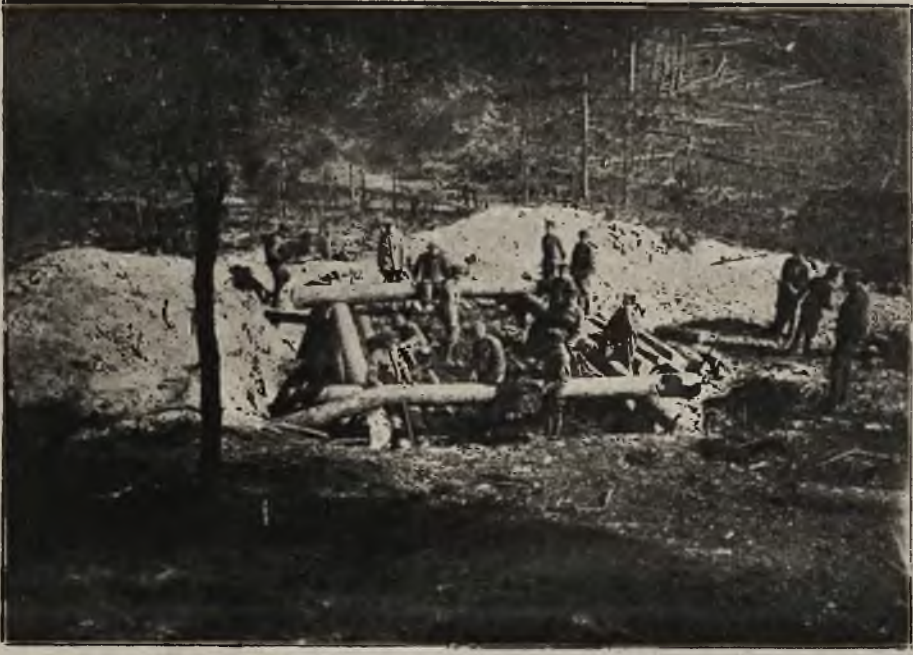
Budowa osłony przed granatami.
