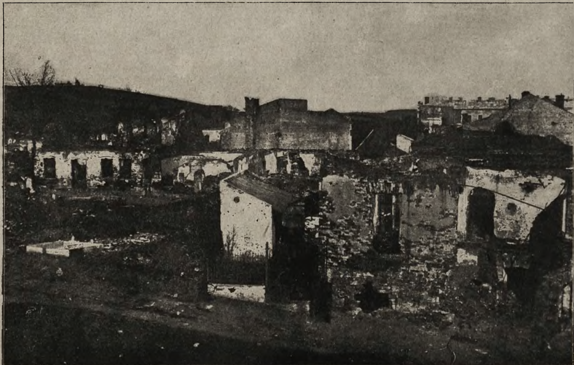
Przed odbudową Galicyi: Obecny widok na ulicę Cmentarną w Gorlicach.
