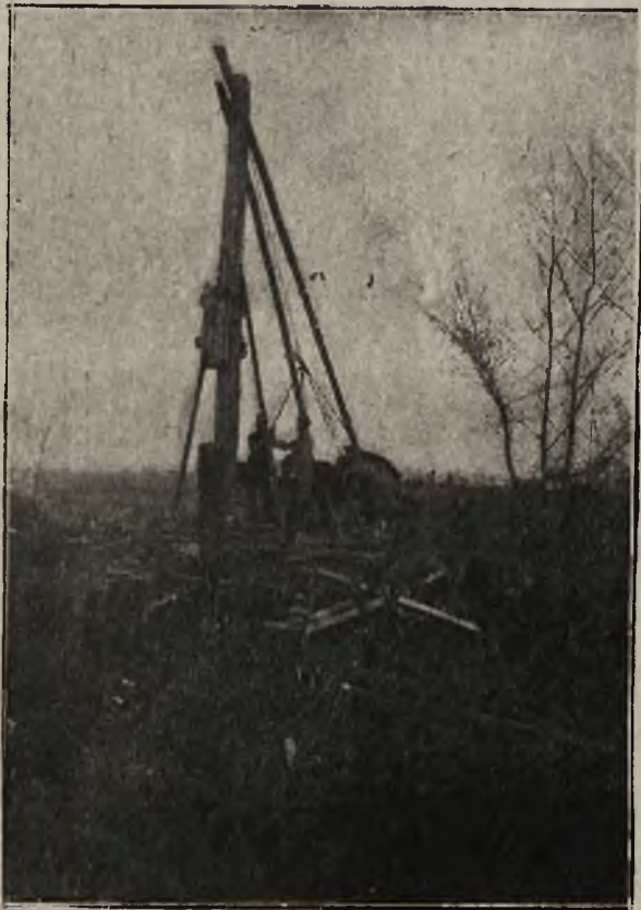
Polscy saperzy: Kompania saperów pierwszej brygady Legionów Polskich przy budowie mostu. (Fot. kap. M. Dąbkowski).
