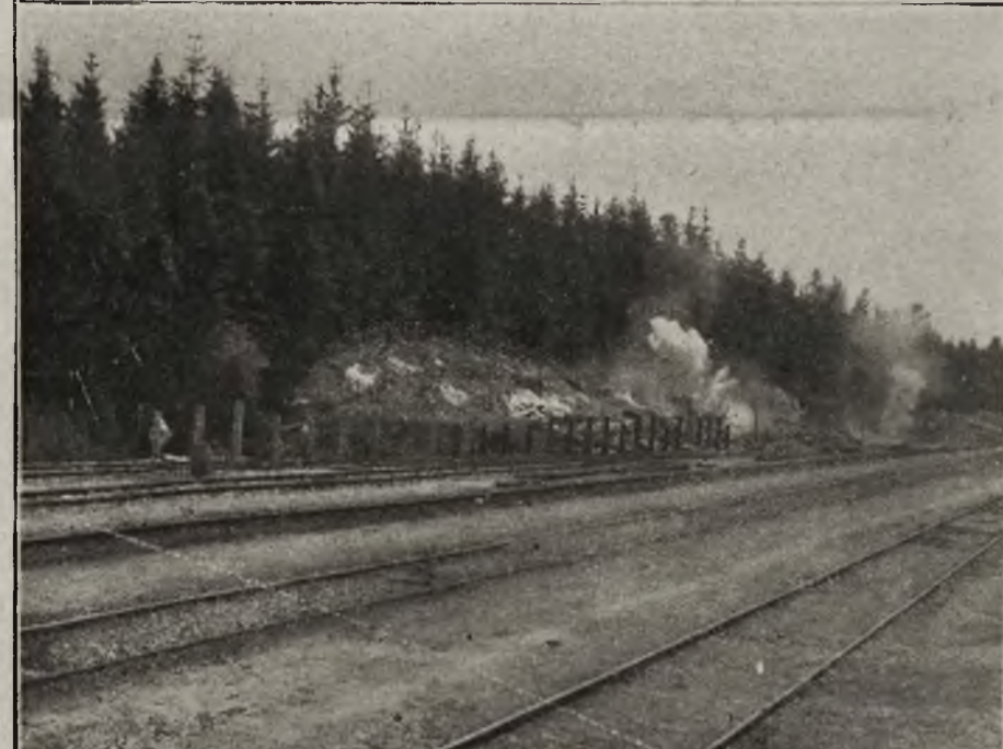
Kłeska Włochów: Rozsadzanie skał na południowym froncie.
