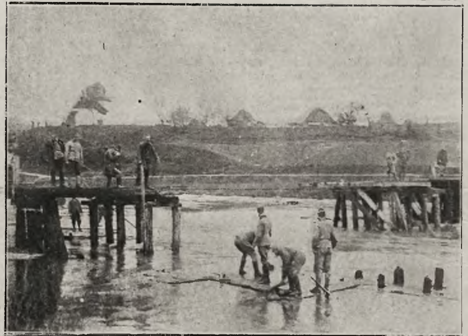
Budowa mostu na Serecie przez 13 p. p.
