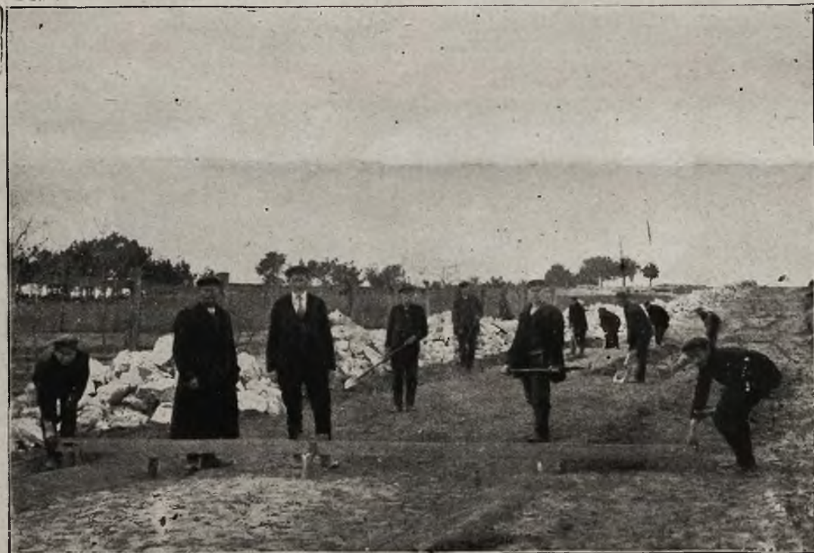
Z gospodarki austriackiej w Królestwie Polskiem: Budowa drogi Gorzkowice-Radomsk.
