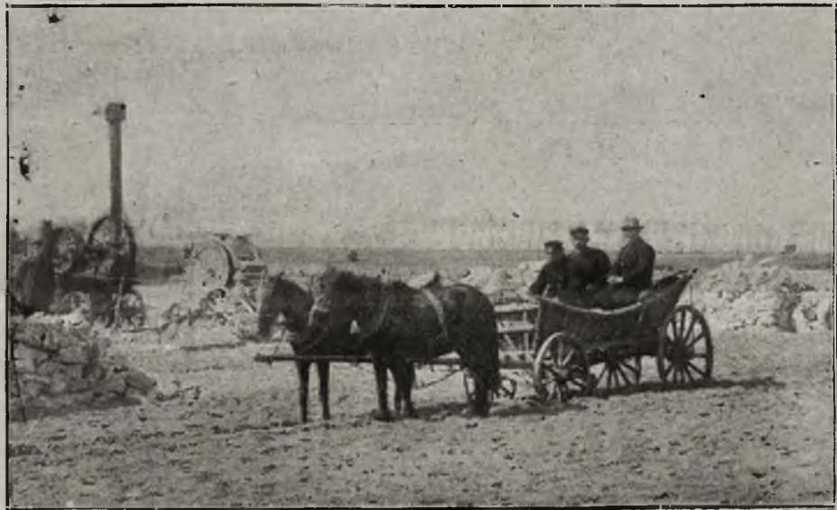
Budowa drogi Gorzkowice-Radomsk.
