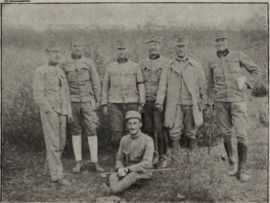
Nasi w Albanii: Grupa oficerów i inżynierów, zajętych przy budowie drogi.
