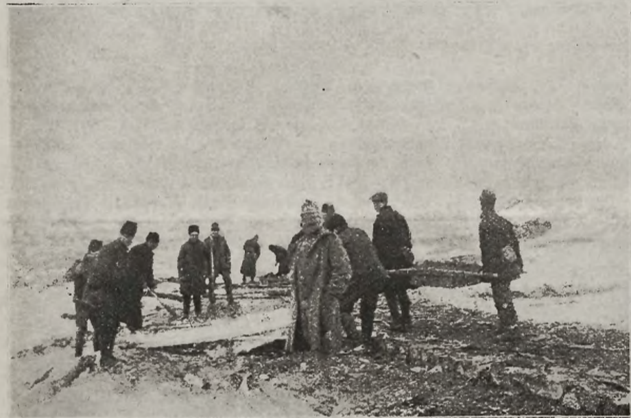
Partya robotnicza przy budowie drogi na wschodnim froncie.
