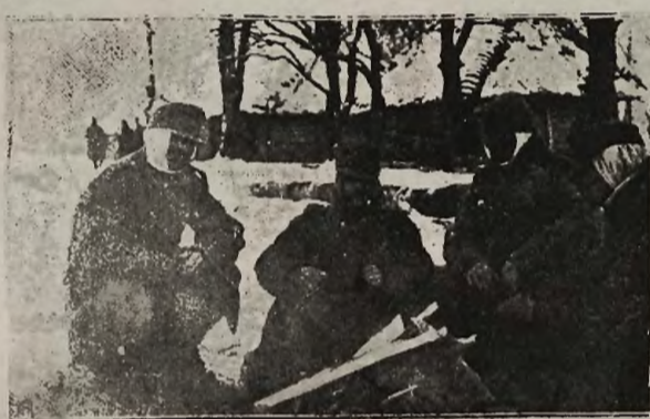
Z frontów bojowych: Żołnierze austriaccy, zajęci budową drogi na wschodnim froncie, podczas odpoczynku. (Fot. inż. Bogdanowicz)
