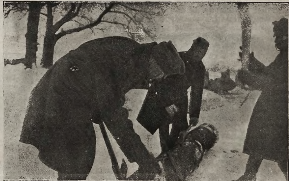
Łupanie kraglaków przy budowie drogi na wschodnim froncie.
