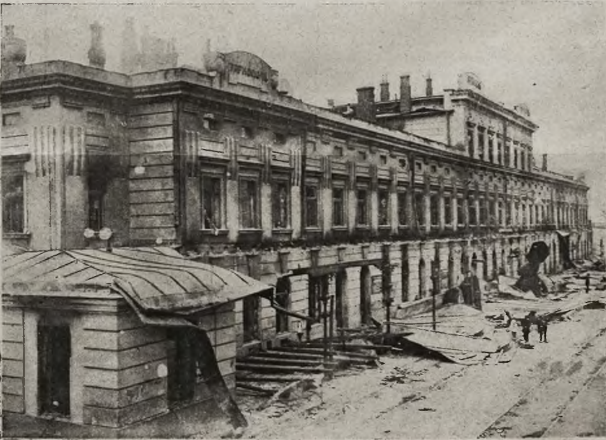
Szlakiem odwrotu Rosyan: Dworzec kolejowy w Tarnopolu po ustąpieniu Moskali. (Fot. Bufa).
