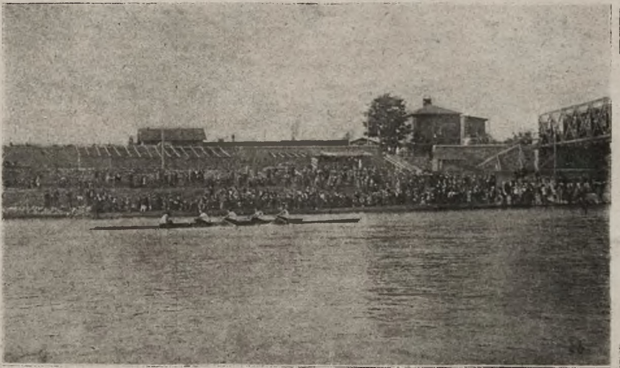
Sport wioślarski w Krakowie: Zwycięska czwórka pań u mety. (Fot. inż. Skibka i Wiśtock).
