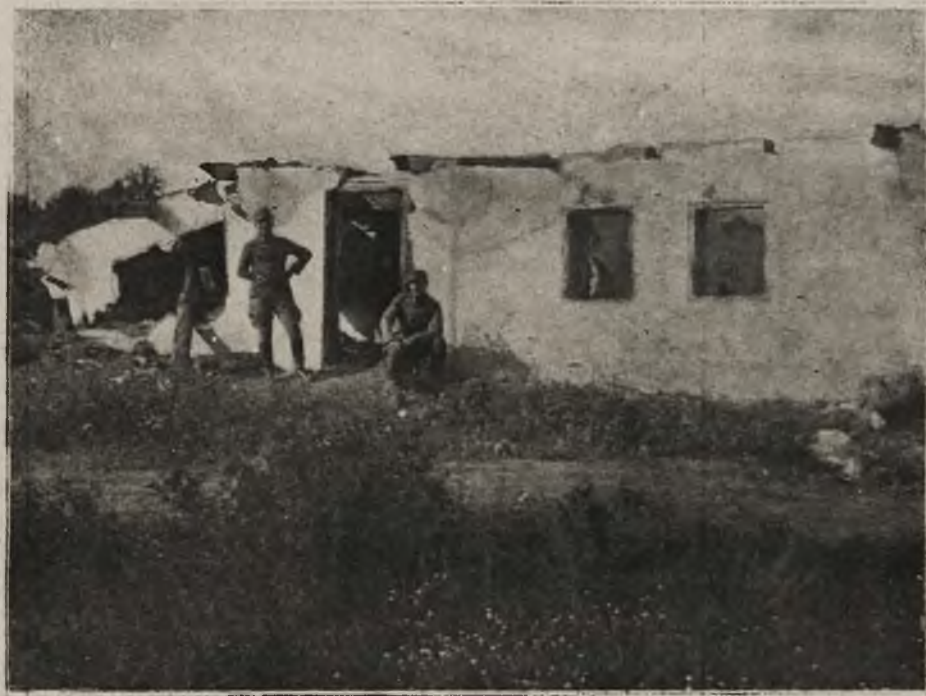
Zniszczona pociskami armatnimi chata w Molodii na Bukowinie. (Zdjęcie, dokonane dnia 5 sierpnia br. po wkroczeniu tamże 13. pułku piechoty)
