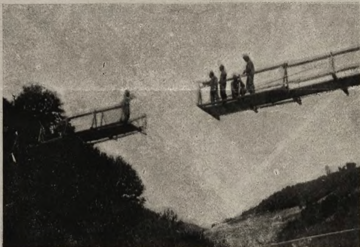
z frontów bojowych: Kładka na linach na wysokości 75 m., służąca do połączenia dwu odcinków frontu, dzieło austriackich pionierów. (Woj. kwat. pras.)
