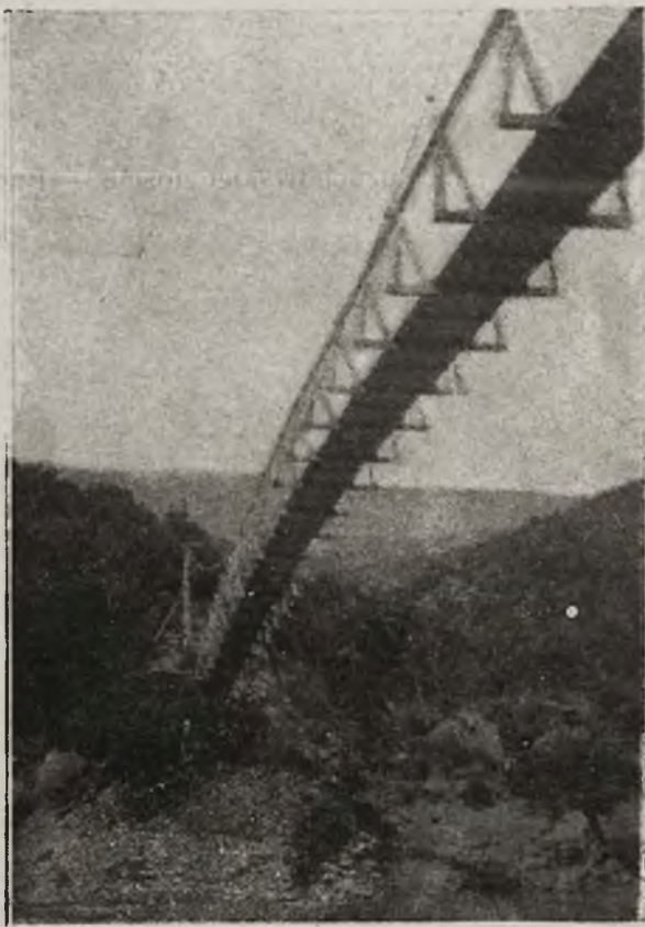
Pogrom Włochów: Kładka na linach, na wysokości 7-5 m, zbudowana przez austriackich pionierów celem połączenia dwu odcinków południowo-zachodniego frontu (Woj. kwat. pras.)
