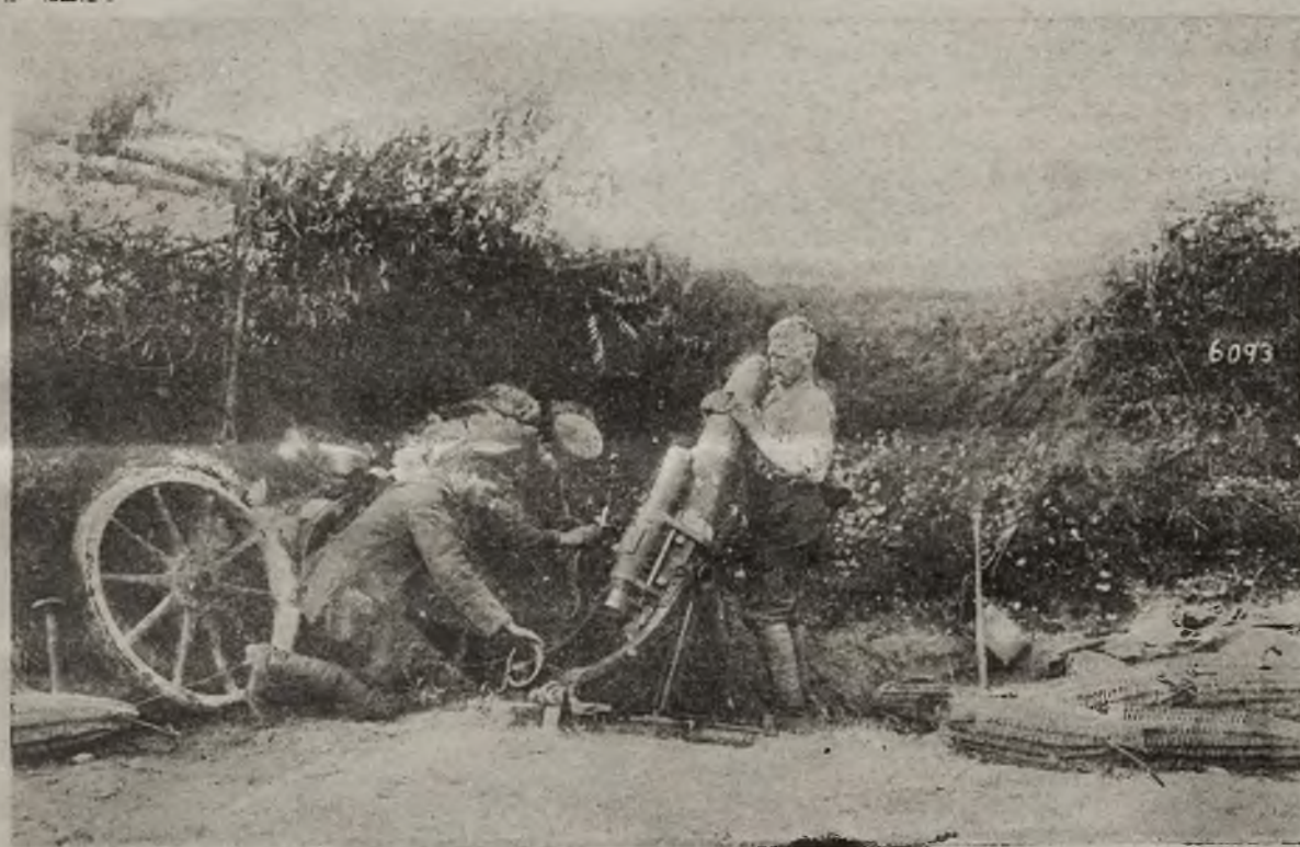
Z frontów bojowych: Montaż min i jego obsługa
