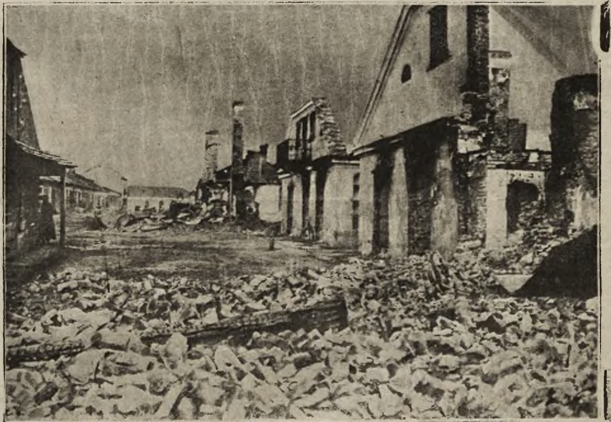
Wyprawa niemiecko-austriacka na Ukrainę: Jedna z osad na Ukrainie, zburzona i spalona przez bandę bolszewików. (Woj. kwat. pras.)
