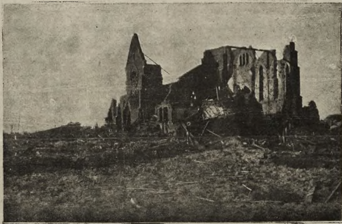
Wielka ofensywa na zachodzie: Ruiny zburzonego pociskami kościoła na terenie walk w Flandryi.
