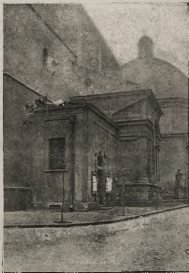
Męczeński Lwów: Uszkodzenia katedry łacińskiej.
