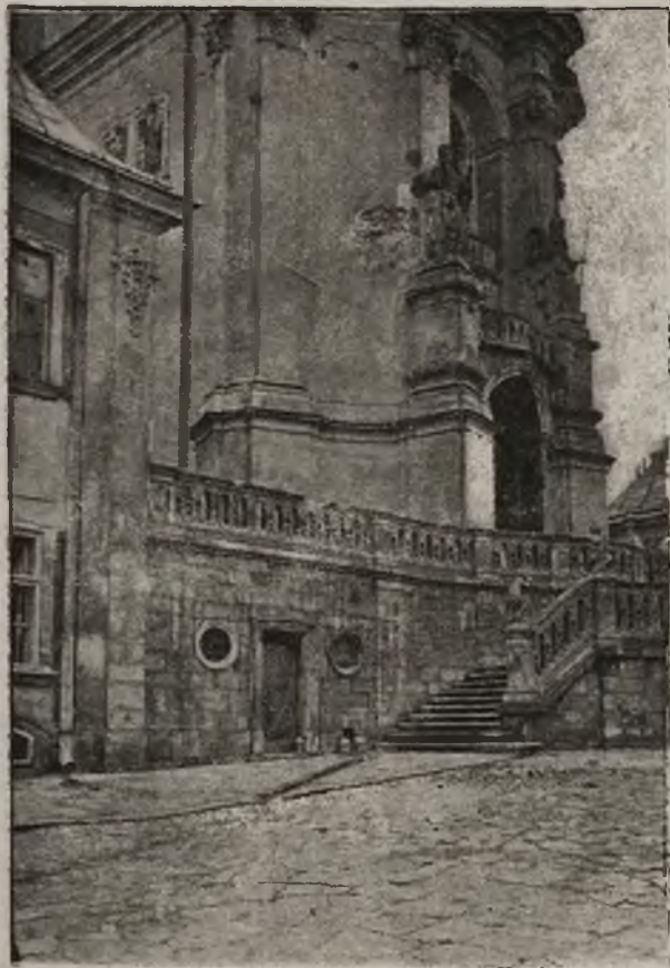
Męczeński Lwów: Uszkodzenia kościoła św. Jerzego.
