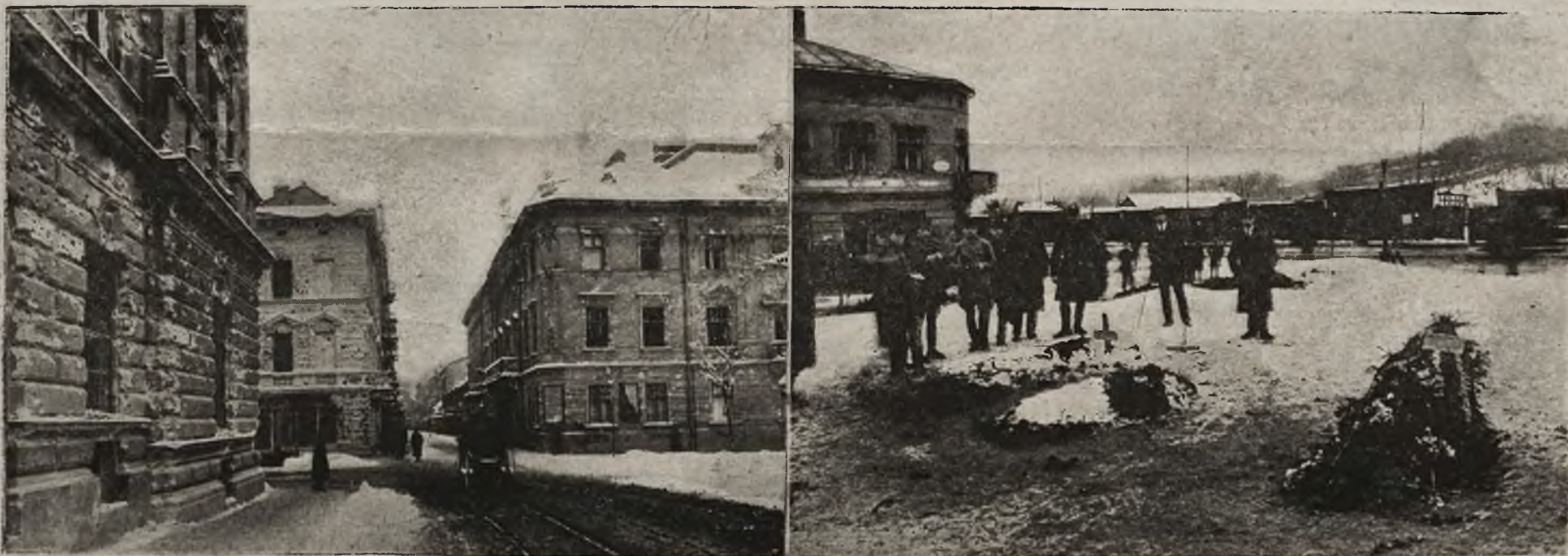
Narożnik poczty głównej zniszczony w czasie walk.
