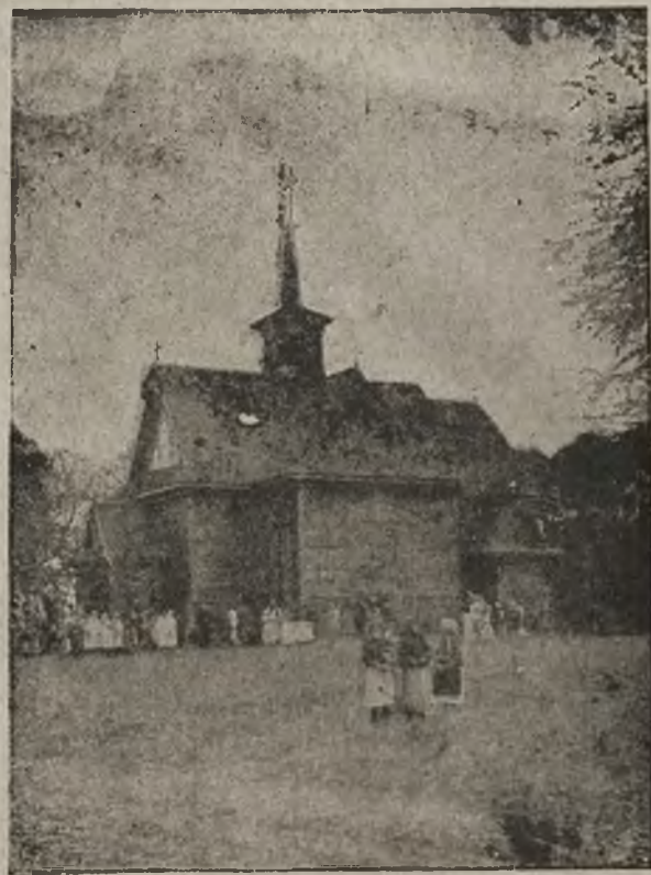
Poświęcenie kościoła w Miłkczynie Nowym: Ogólny widok kościoła.
