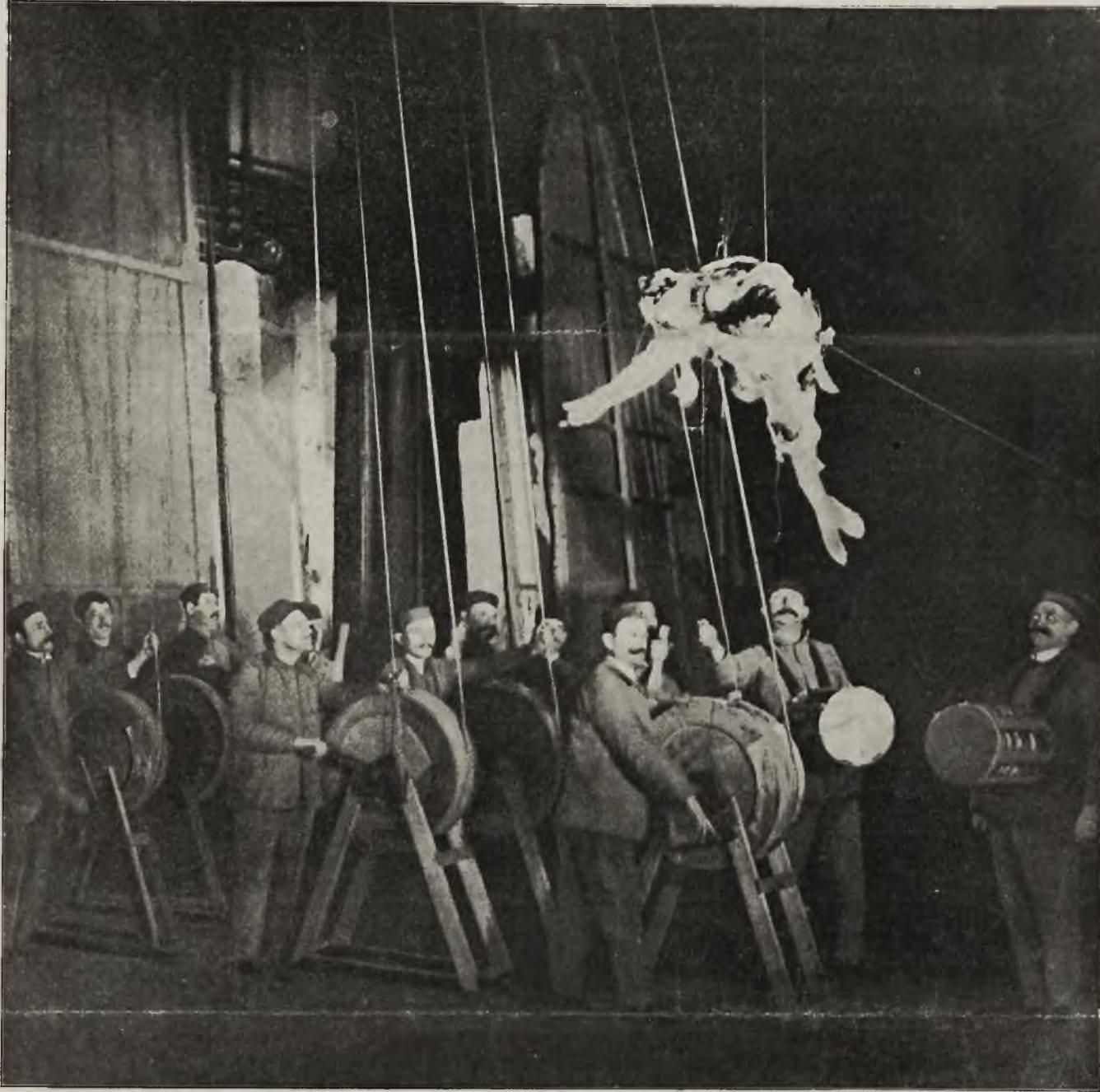
Z tajemnic zakulisowych: W operze królewskiej w Budapeszcie, próba nowego mechanizmu, który umożliwia przepływanie syren prz z rzekę na scenie. (Fot. Békel Ödön Budapeszt.)
