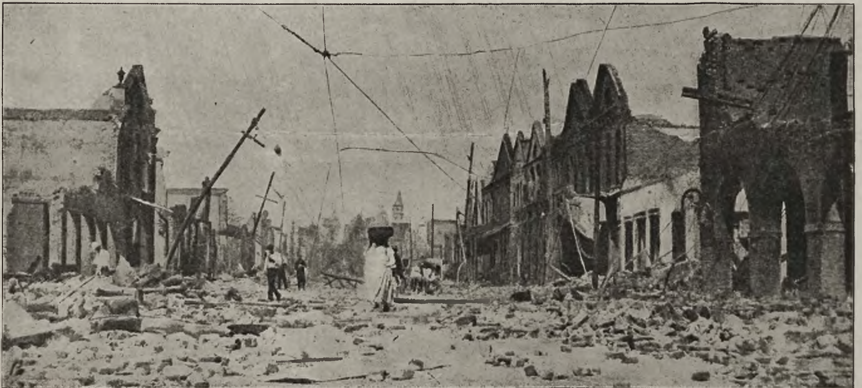
Obrazy zniszczenia: Jak wyglądały ulice w Kingstonie po trzęsieniu ziemi.
