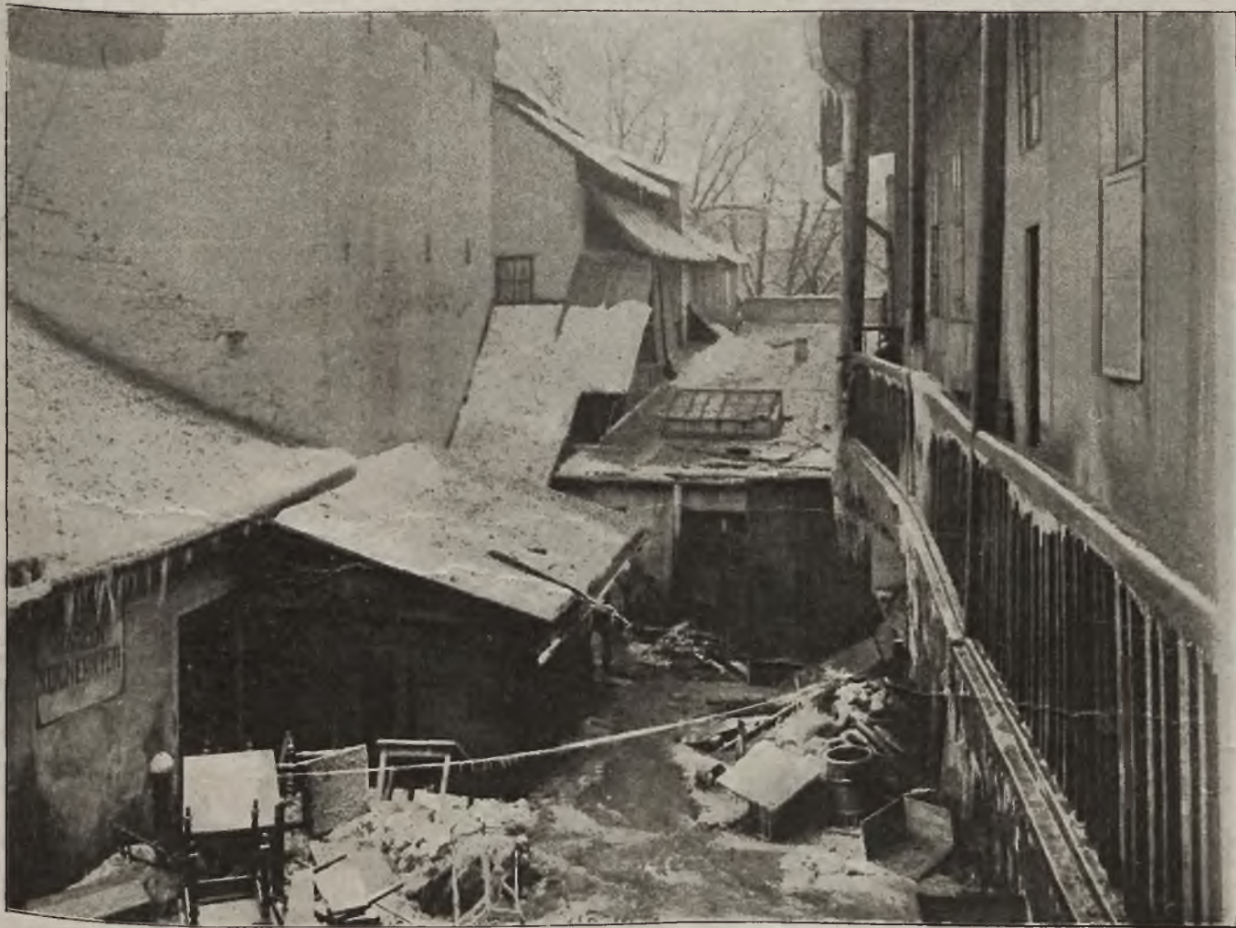
Pożar kawiarni Drobnera: Po pożarze widok dziedzińca domu Drobnera z magazynem materiałów łatwopalnych, które groziły największym niebezpieczeństwem.
