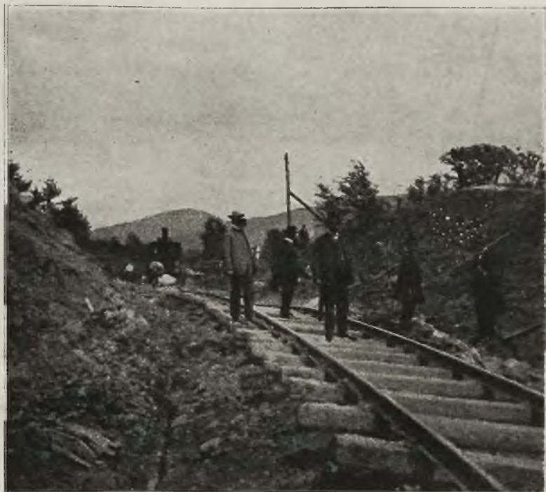
Katastrofa kolejowa pod Jaremczem: Komisja kolejowa bada uszkodzony tor, którego nienormalne wzniesienie doskonale widać.
