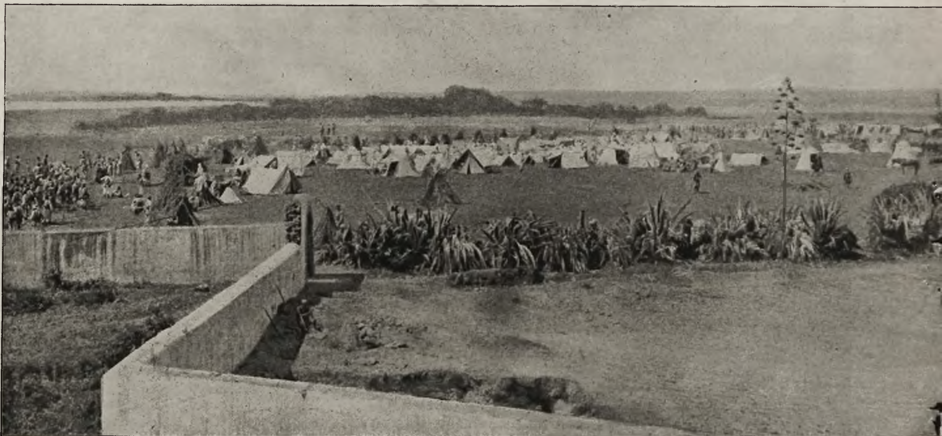
Z pod murów Casablanca: Ogólny widok.
