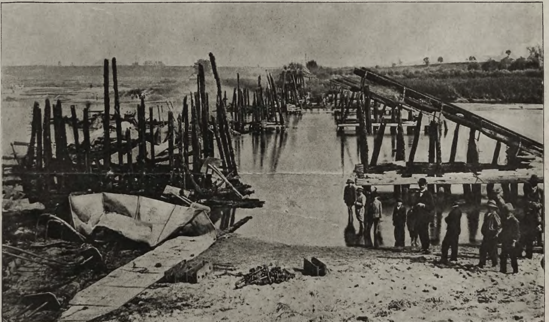
Pożar na rzece: Most na Sanie po spaleniu się.
