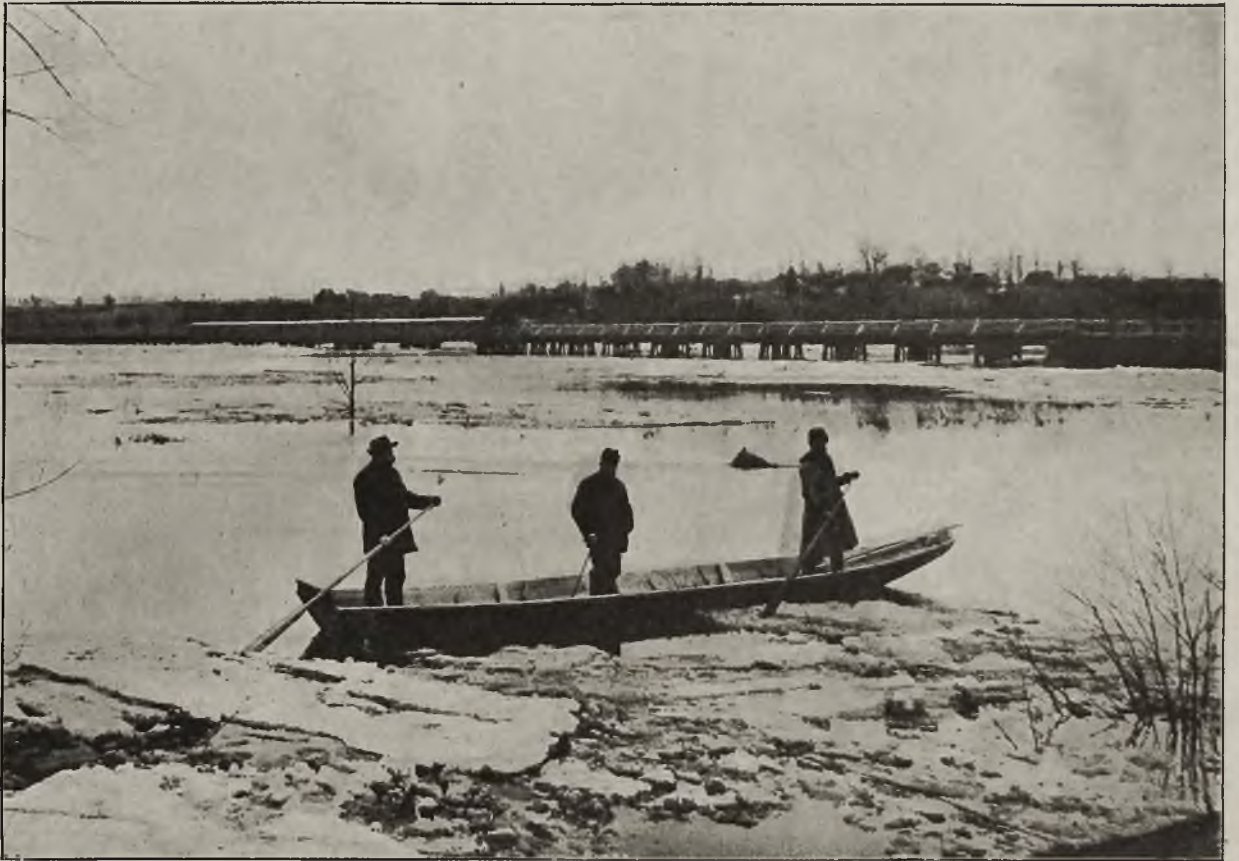
Pożar na rzece: Most na Sanie przed pożarem.
