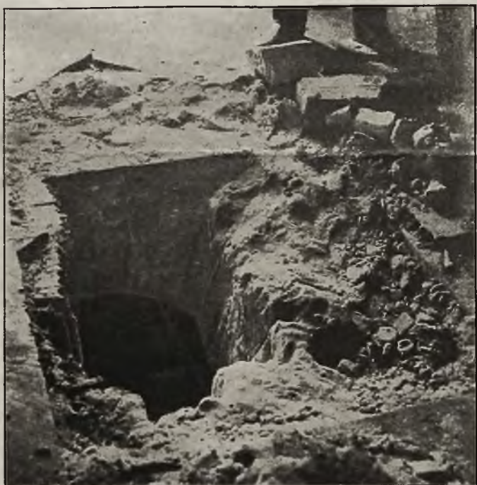
Obrabowanie banku w Krakowie: Wylom w podłodze I. piętra, którędy włamywacze dostali się do kantoru.
