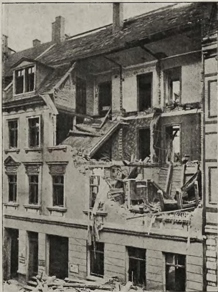
Wybuch gazu: Widok zburzonego wybuchem domu
