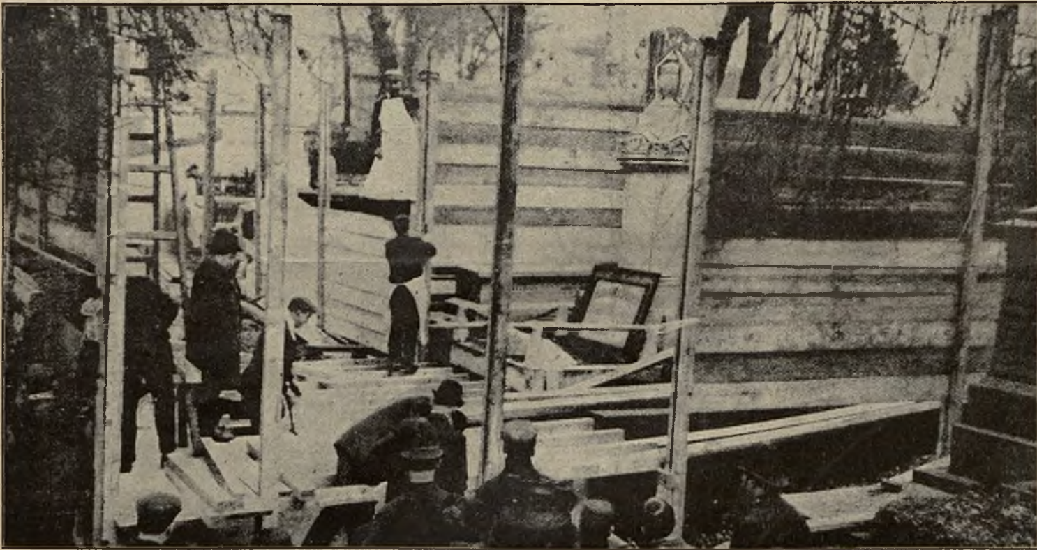
Proces o zwłoki: Budowanie szopy nad grobem.
