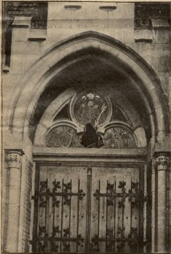
Świątokradzki wandalizm: Szczyt drzwi kościelnych z uszkodzonym witrażem.
