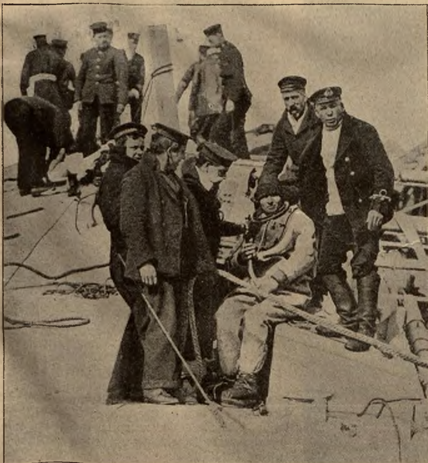
Strasne zderzenie na morzu: Nurkowie przed spuszczeniem się do wnętrza zatopionego pancernika.
