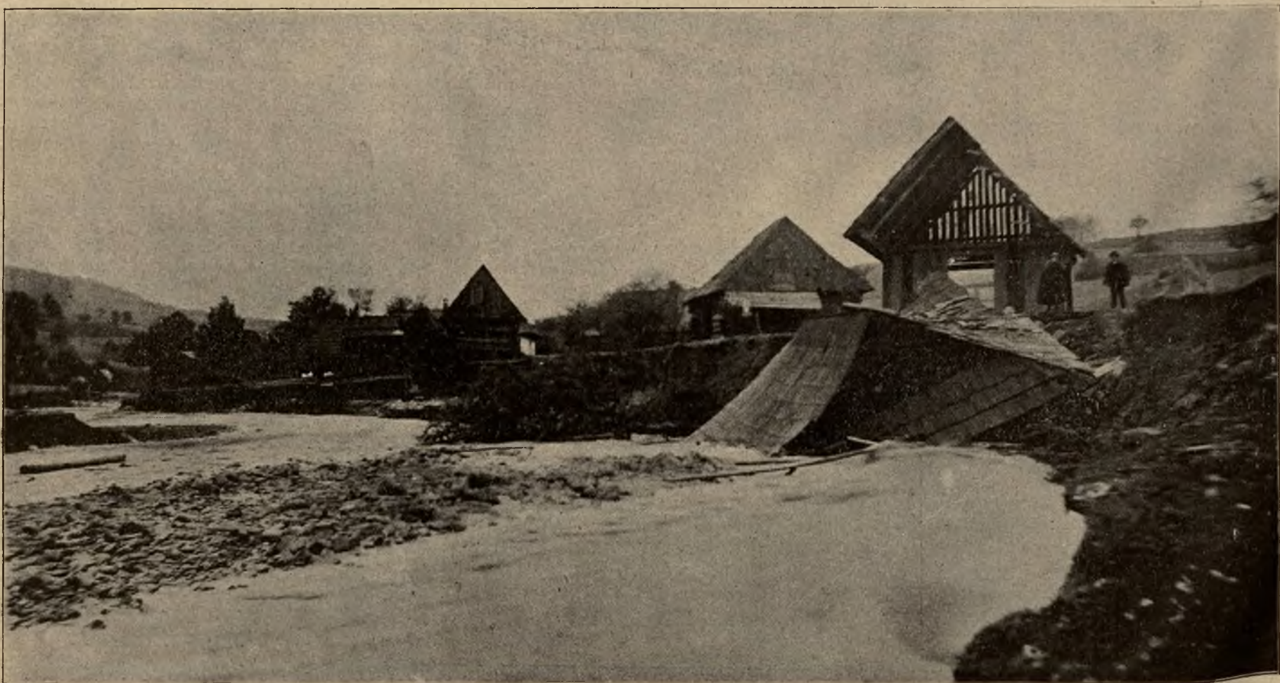
Katastrofa w Juszczyńcu: Widok Juszczyzny po powodzi.
