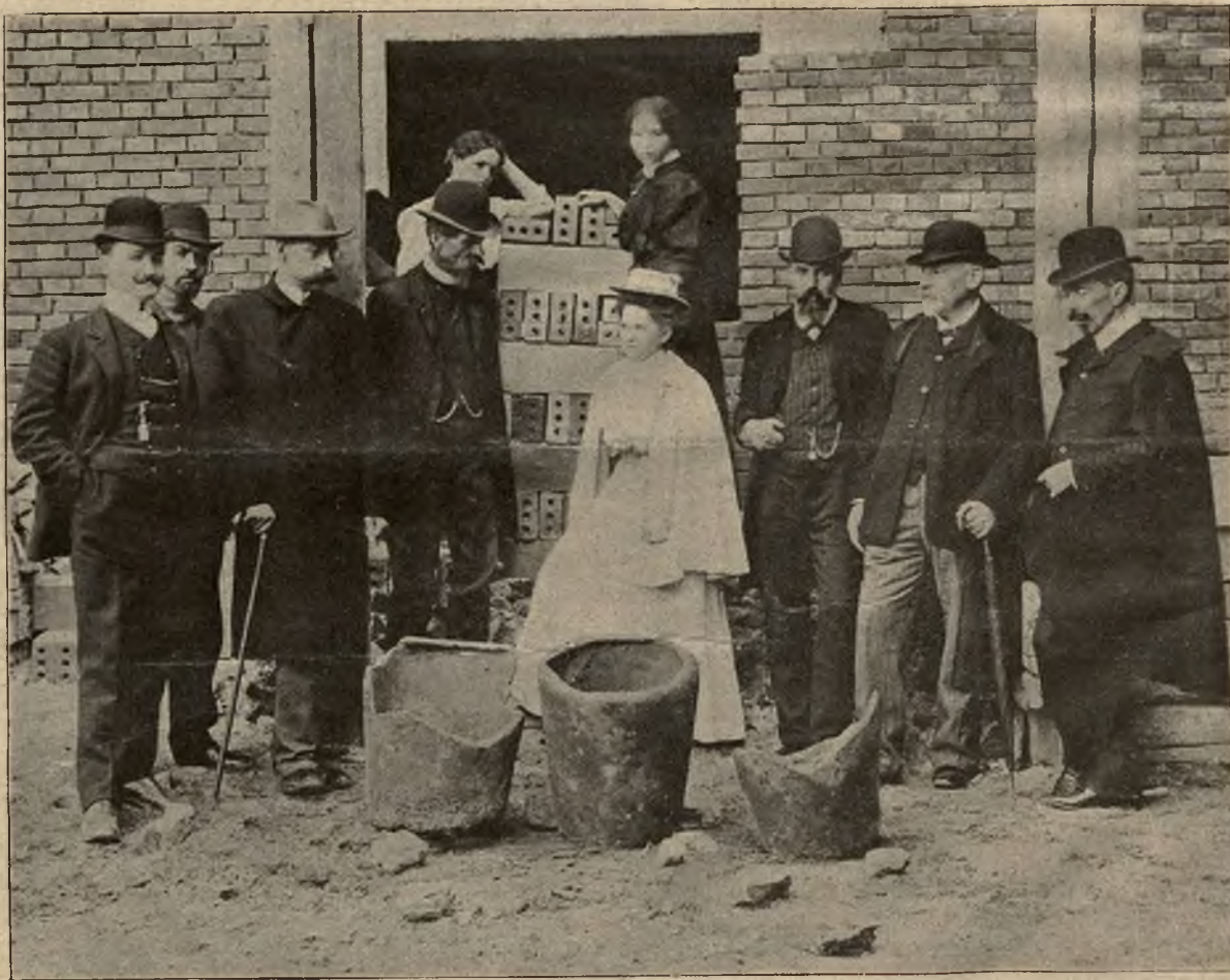
Wykopaliska w Warszawie: Komisya »starej Warszawy« przy znalezionych w starej mennicy tyglach, służących do topienia metali.
