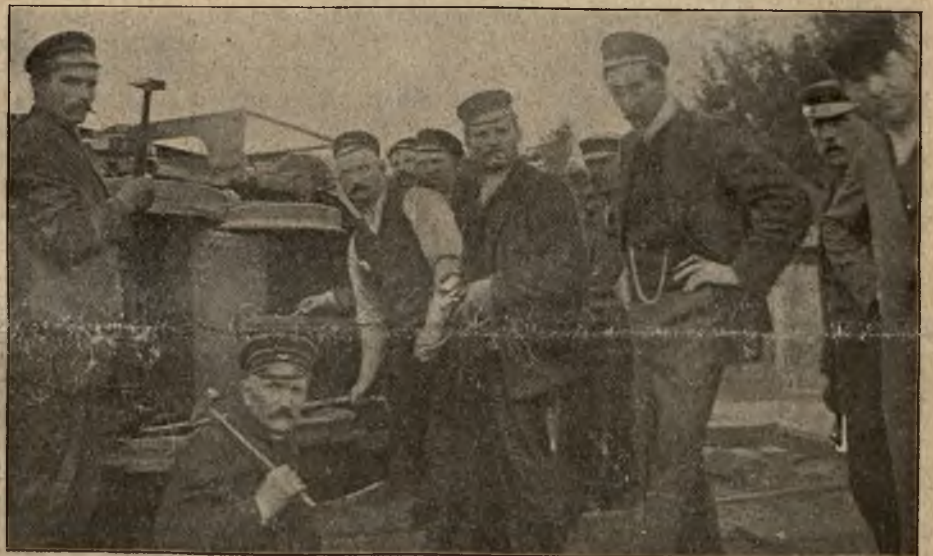
Wypadek kolejowy pod Warszawą: Praca około podniesienia lokomotywy.
