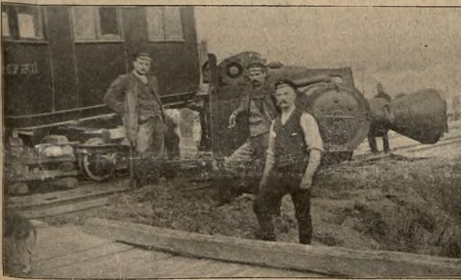
Wypadek kolejowy pod Warszawą: Widok ogólny miejsca katastrofy.
