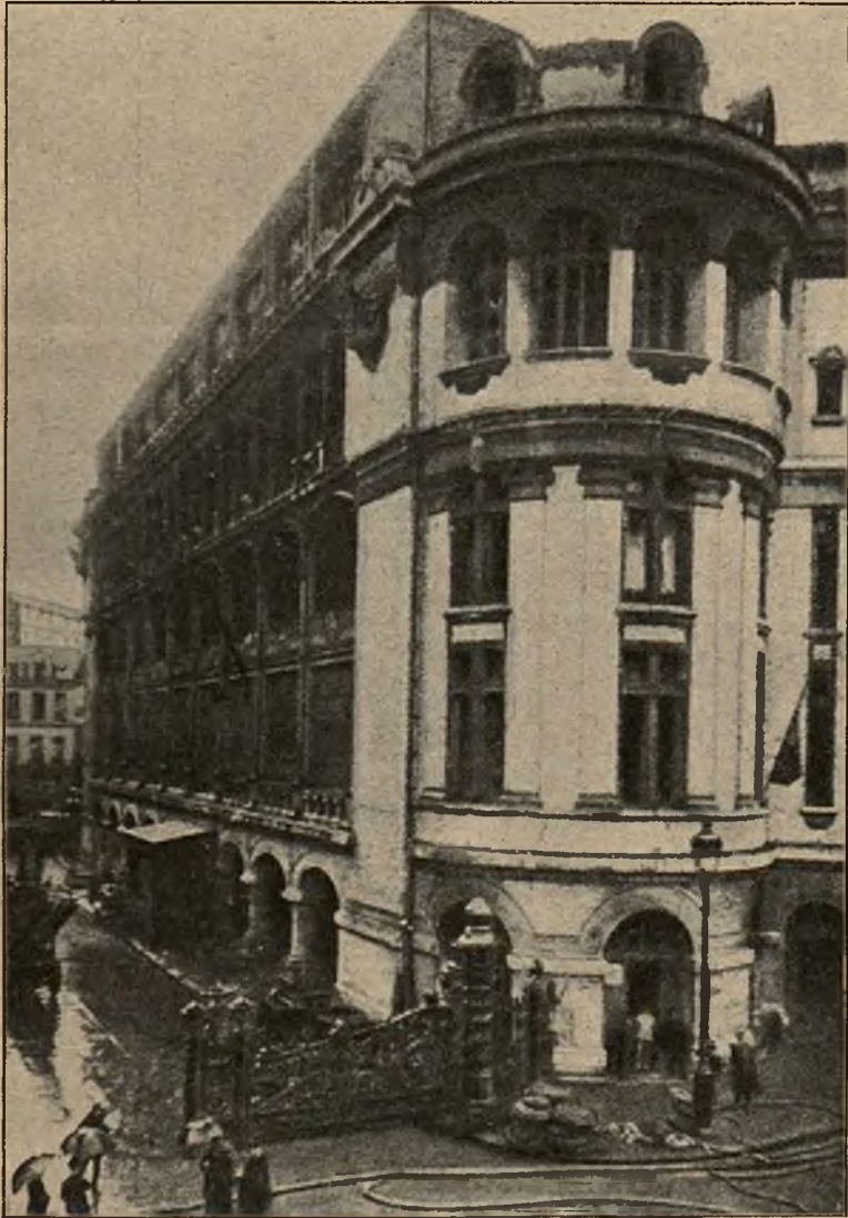
Pożar centrali telefonów w Paryżu: Ogólny widok zniszczonego gmachu.
