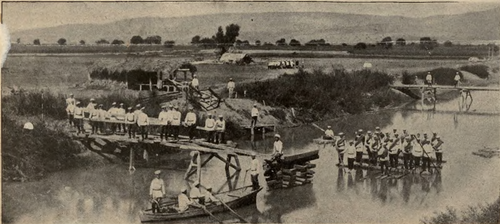
Kryzys turecko-bułgarski: Bułgarscy pontonierzy przy budowie mostu.
