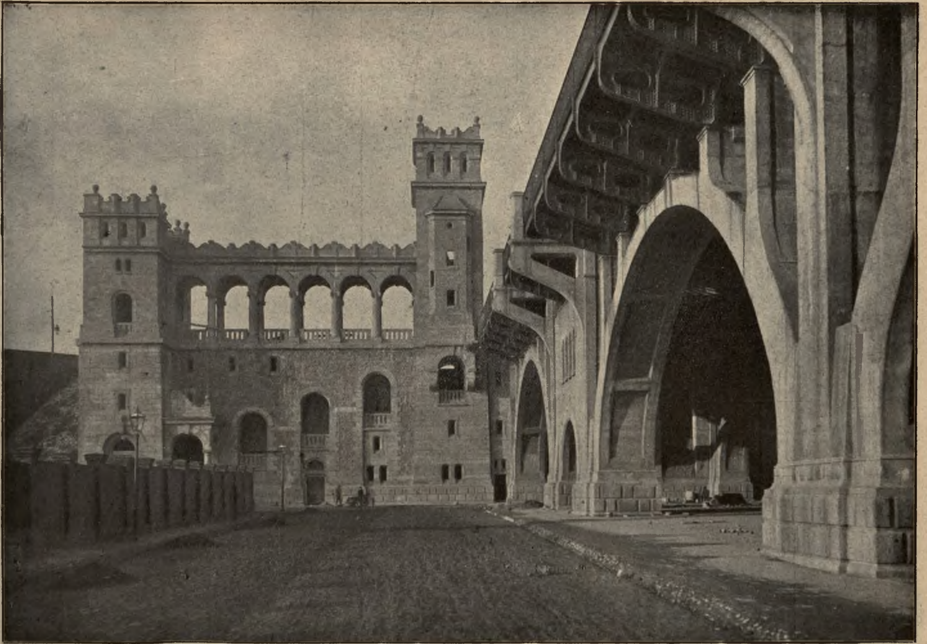
Nowy most w Warszawie: Przyczółek wiaduktu.
