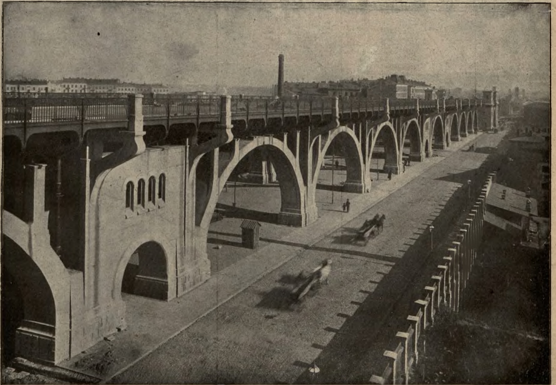
Nowy most w Warszawie: Ogólny widok wiaduktu.
