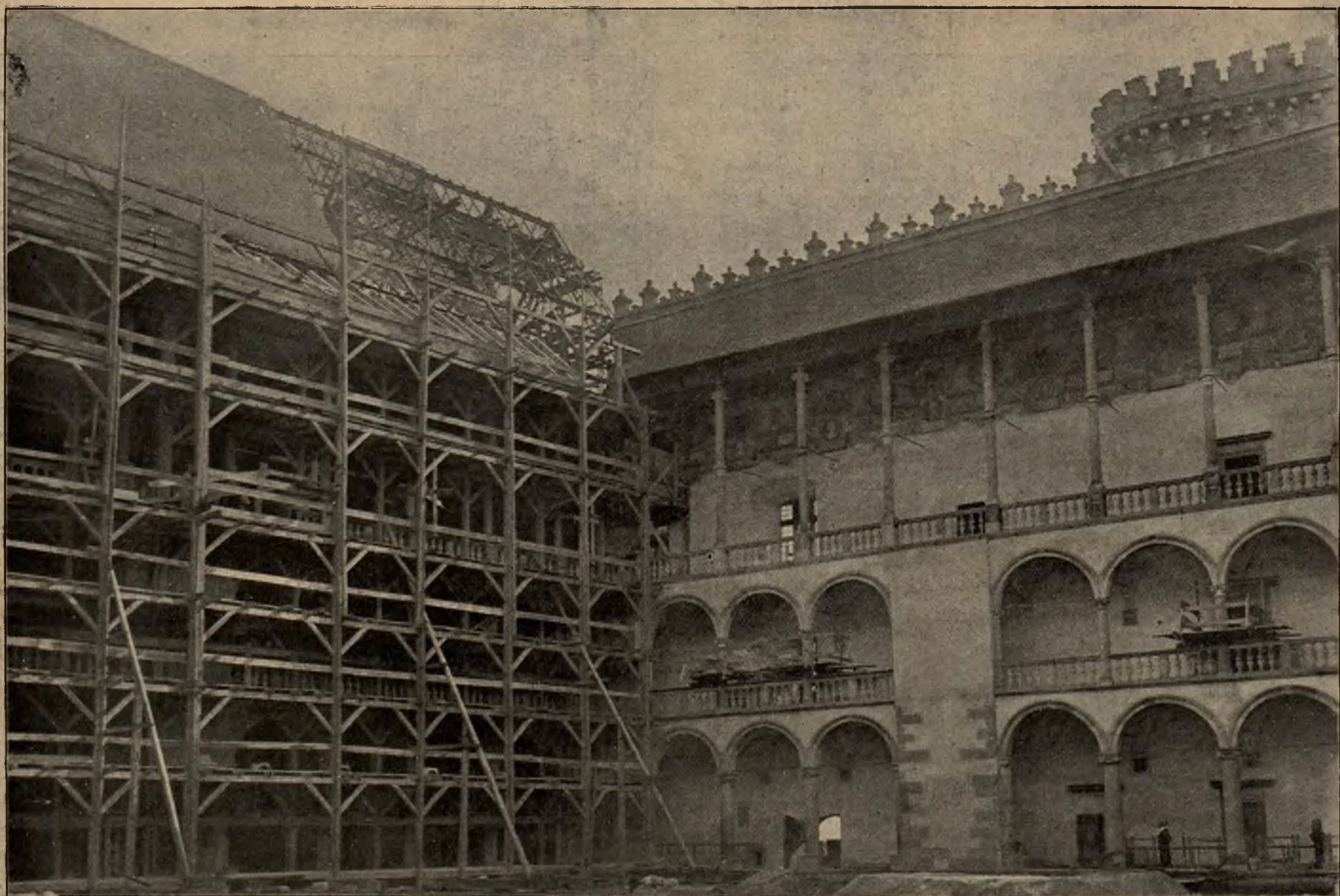
Wawel dziś i w przyszłości: Częściowo zasłonięty jeszcze rusztowaniem dziedziniec turniejowy.
