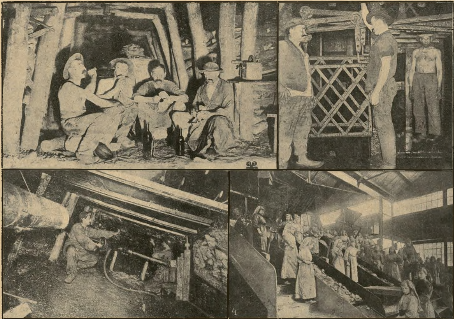
Nasi górnicy we Francji. Zdjęcie z kopalni francuskich Compagnie Courrières. 1) Śniadanie w kopalni. 2) Winda na podszybiu z francusko-polską obsługą. 3) Robienie wrębu w ścianie pokładu. 4) Sortowanie węgla przez rotolnice francuskie i polskie.
