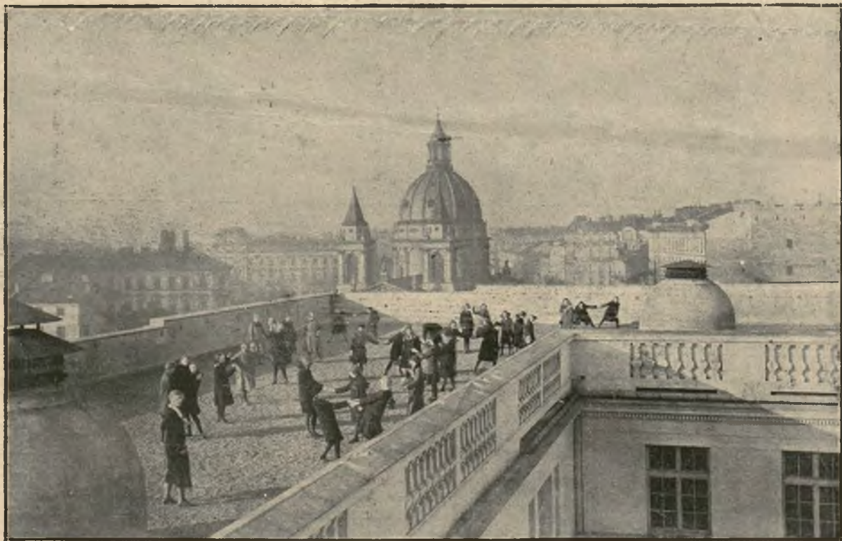
Nowoczesny gmach szkolny w Warszawie: Nowo wybudowany gmach gimnazjum królowej Jadwigi w Warszawie posiada na wzór amerykański na tarasie dachu plac przeznaczony do zabaw.
