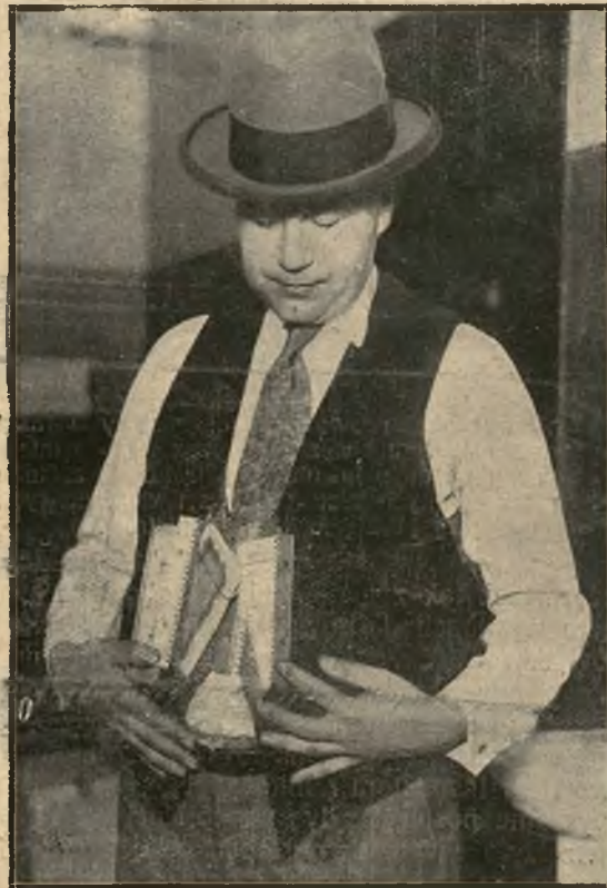
Safe depozytowy w kamizelce. Wobec ciągłego niebezpieczeństwa napadów rabunkowych w Ameryce wynaleziono tam dla posłańców, przynoszących większe kwoty pieniężne specjalne kamizelki, mieszczące w sobie silnie przymocowane stalowe safy depozytowe. Klucz od tego „kamizelkowego” safu, znajduje się w banku i u odbiorcy przesyłki pieniężnej, tak, że nawet posłaniec nie jest w możności otworzenia skrytki.
