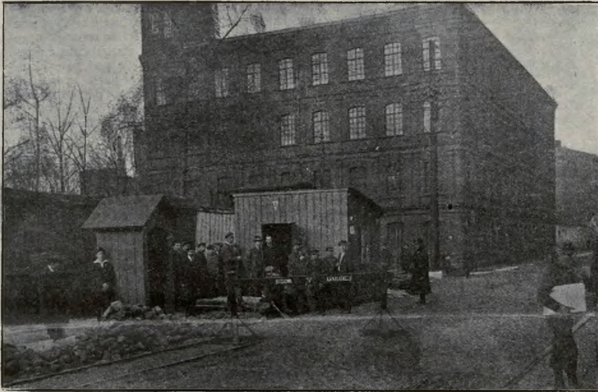
Łódź „europelzu,e” sę: Polski Manchester dotychczas nie posiadał kanalizacji. Dopiero w ubiegłym tygodniu magistrat przystąpił do skanalizowania Łodzi. Budowy potrwać 4 lata.
