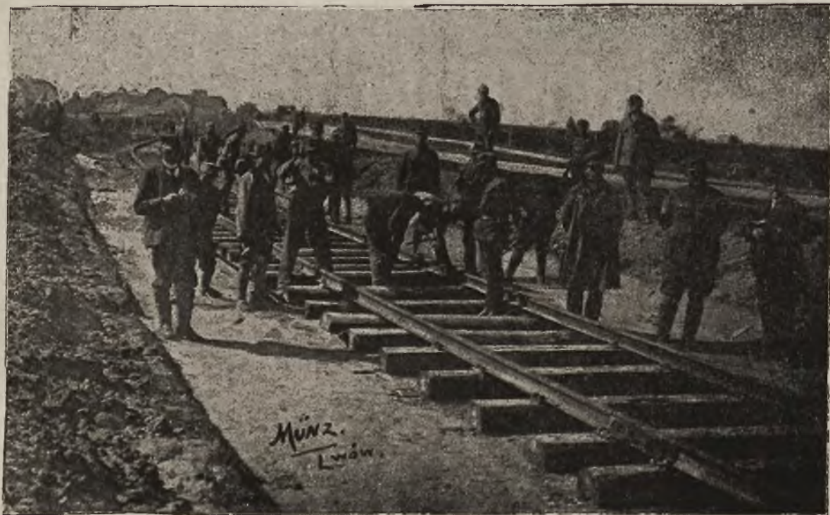
„Targi Wschodnie” we Lwowie: Położenie kolejowego toru na Plac Powystawowy, gdzie się ma odbyć Targ Wschodni.
