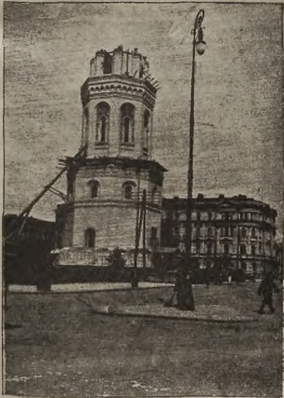
Usuwanie pamiątek naszej niewoli: Prace około barzenia dzwonicy byłego soboru prawosławnego na Placu Saskim w Warszawie.
