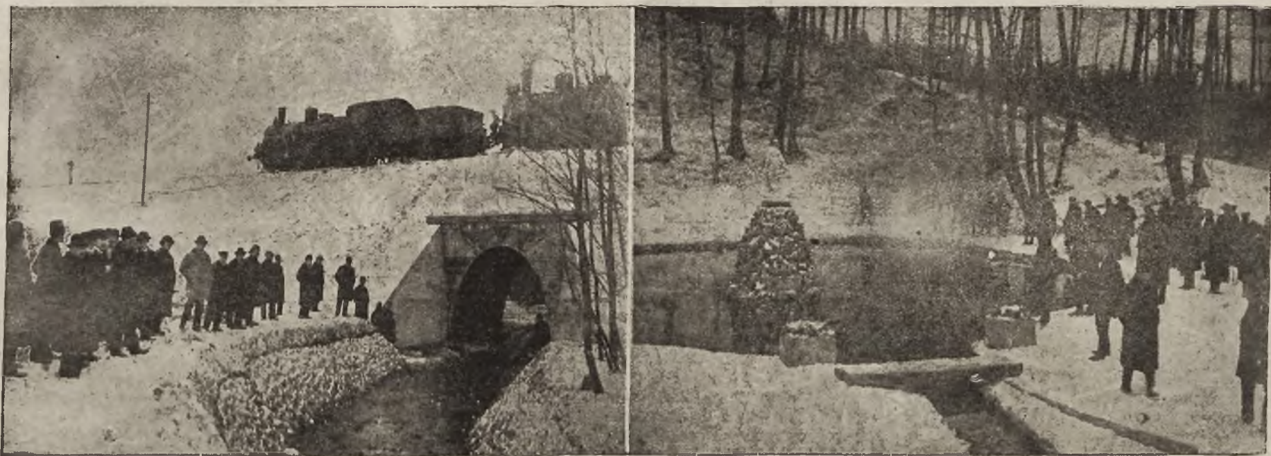
Poświęcenie linii kolejowej Kokoszków-Gdynia: 1) Przepust pod Wielkim Rackim, dzieło naszych inżynierów. 2) Źródło zwane dawniej „Kaiserquelle“, na 18. kilometrze, ujęte przez naszych inżynierów w basen, ozdobione figurą Matki Boskiej i nazwane obecnie Jej Imieniem. Aj. fot. Maryan Fuks, Warszawa.
