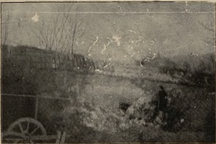
Mur klasztorny uszkodzony granatem.
