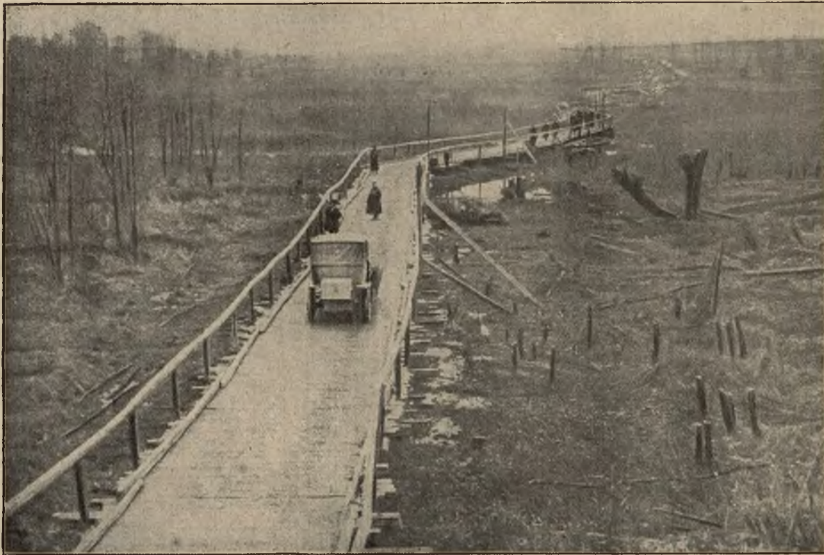
Z zachodniego terenu walki: Most na zatopionym przez Francuzów terenie nad Yserą, zbudowany przez niemieckich pionierów w przeciągu pięciu dni.
