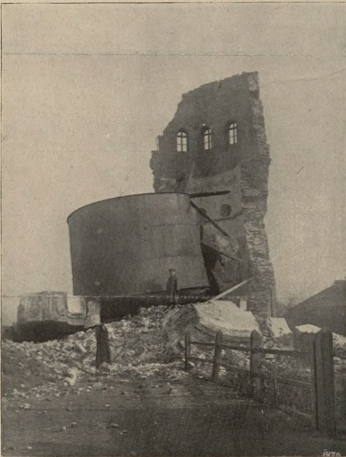
Ze zbombardowanej Łodzi: Wysadzona dynamitem wieża wodna na dworcu kolei kaliskiej w Łodzi.
