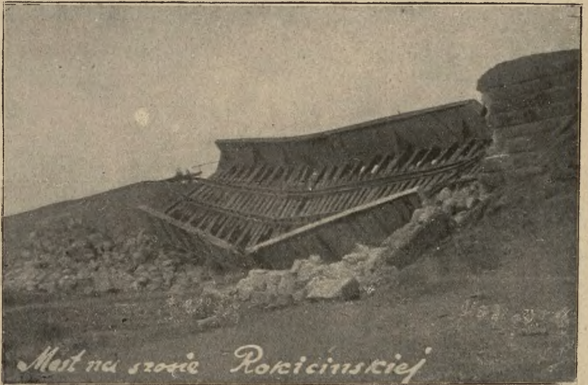
Ze zbombardowanej Łodzi: Most kolei obwodowej w Łodzi nad szosą, prowadzącą do Koluszek, wysadzony w październiku 1914 r.
