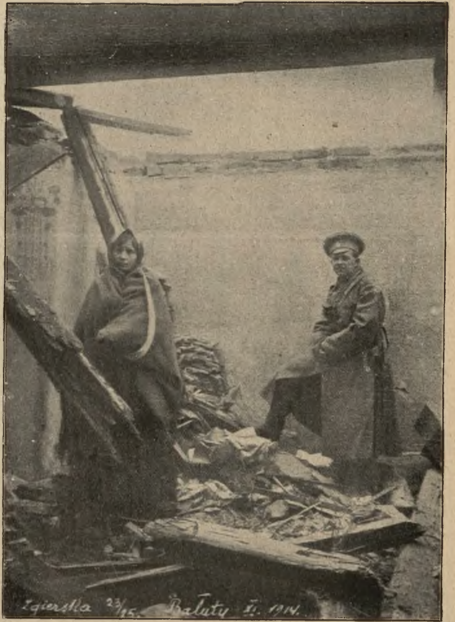
Skutki wybuchu granatu w domu l. 23—25 przy ul. Zgierskiej.
