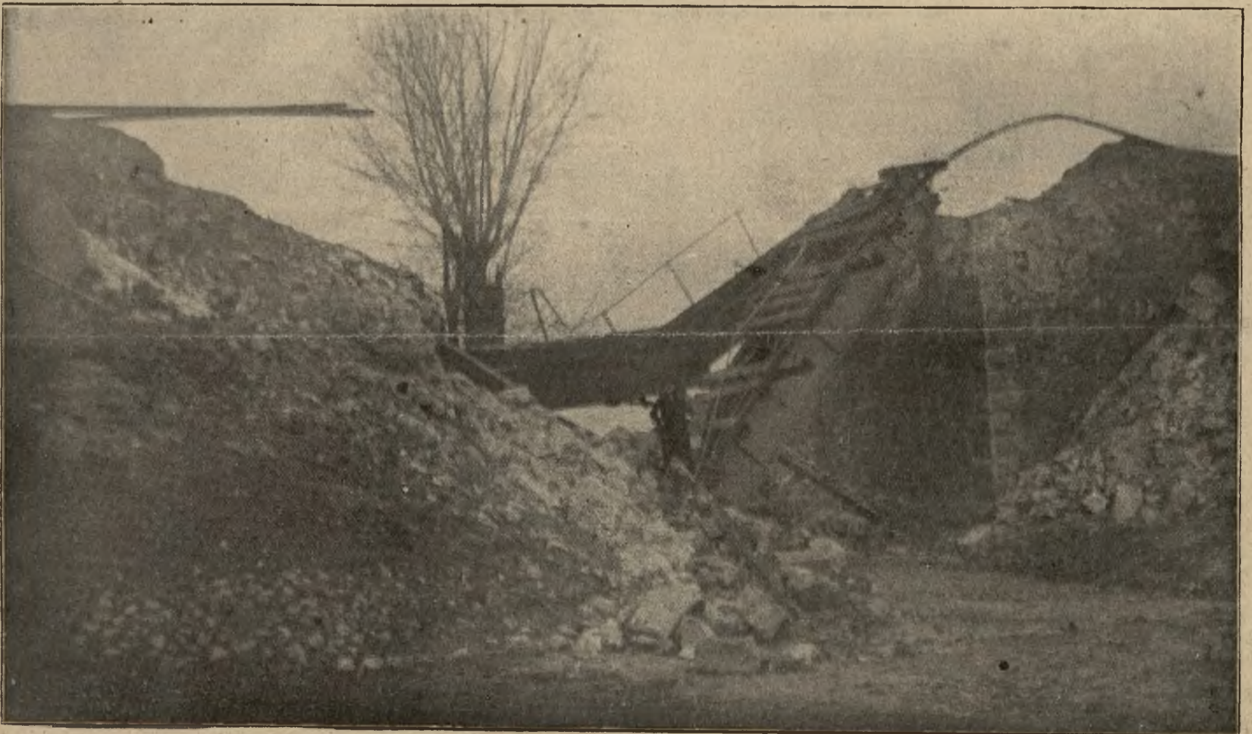
Ze zbombardowanej Łodzi: Zniszczony most na ulicy Obywatelskiej w Łodzi.
