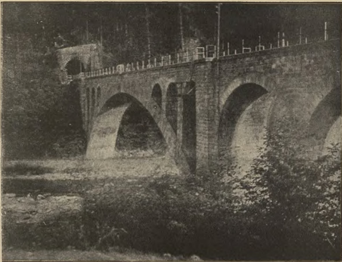
Z terenu walk w Galicyi Wschodniej: Jamna. Tunel i wiadukt kolejowy. (Na linii Nadwórna - Körösmeső).
