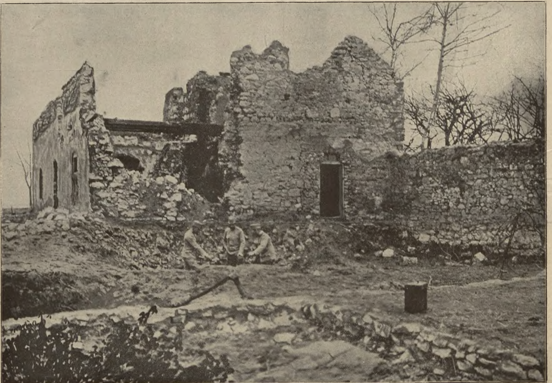
Dwór w Poskitowie, zburzony pociskiem 30 1 / 2 centymetrowego moździerza austriackiego.
