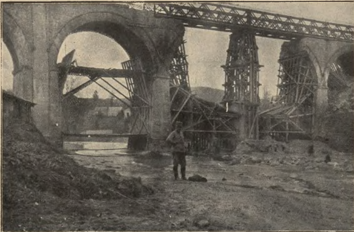
Pogrom Rosyan w Galicji: Wiadukt kolejowy koło Grybowa, odbudowany przez austro-węgierskich saperów.
