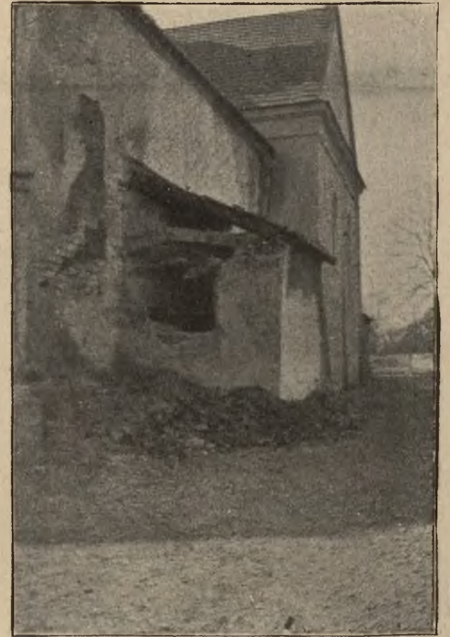
Po inwazji Rosyan: Podziurawione mury zniszczonego kościoła w Wojniczu.
