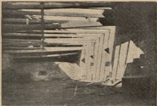
Po inwazji Rosyan: Zniszczone urządzenie browaru w Wojniczu.
