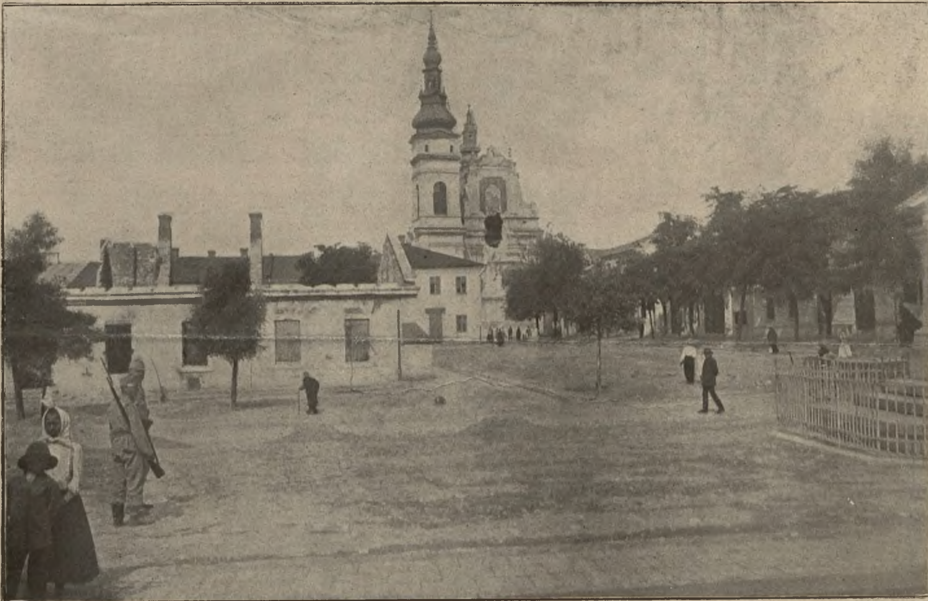
Rynek w Tarnobrzegu z widokiem uszkodzonego kościoła i spalonego ratusza.
