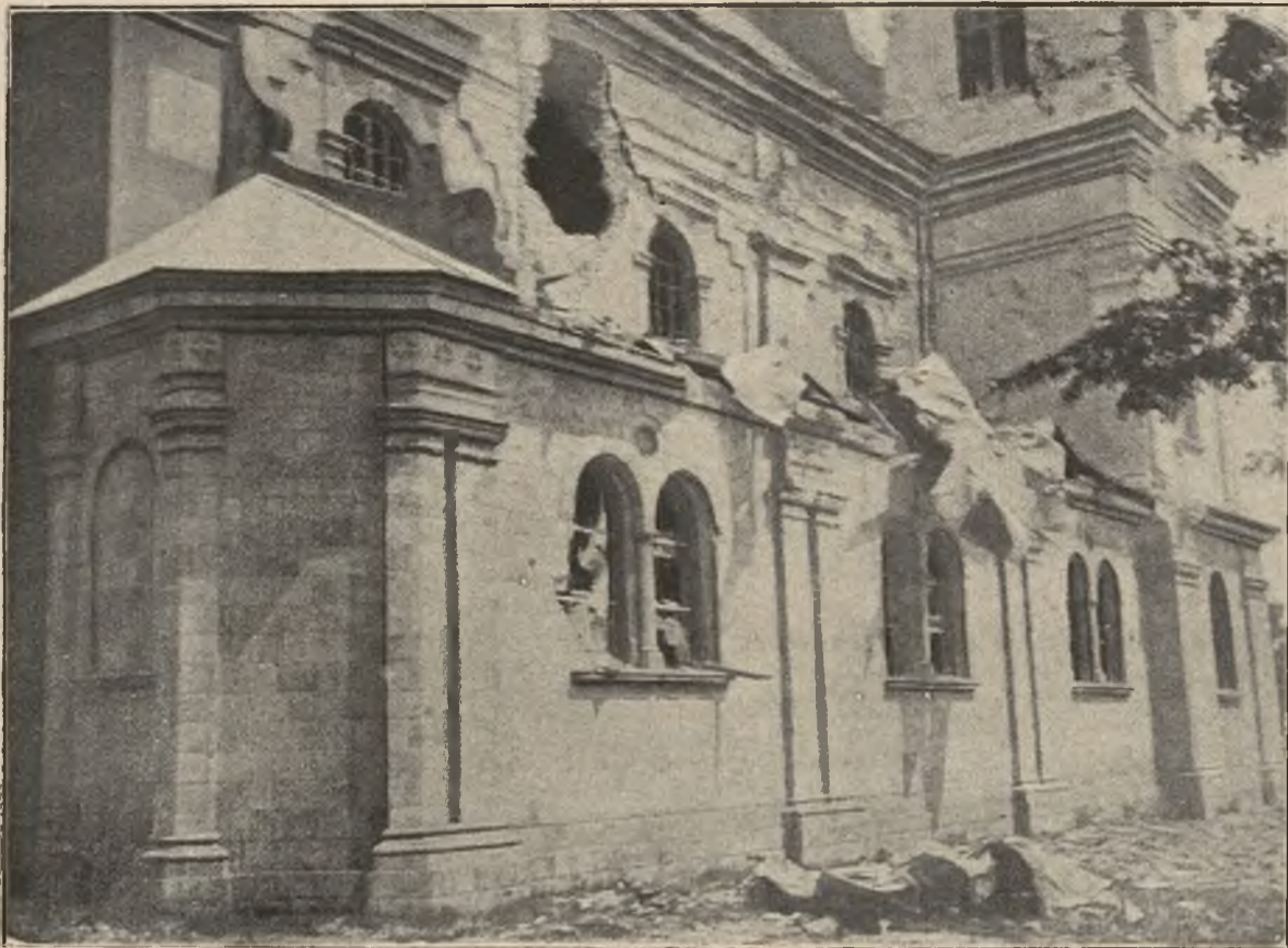
Zewnętrzny widok zniszczonej bocznej nawy kościoła O. O. Dominikanów w Tarnobrzegu.
